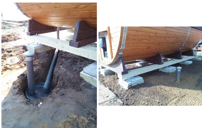
Фото отвода воды \varnothing 40 мм в местную канализацию.
